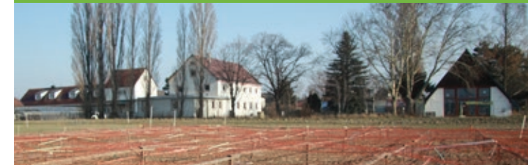
(li.) Bürogebäude mit Seminarraum, Labor-/Bürohaus, Besucherzentrum
